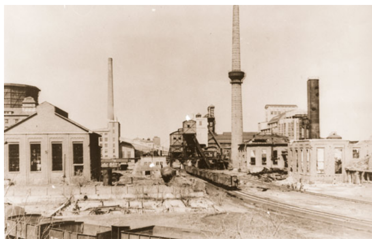
Abb. 3: Zerstörte Kokereianlagen auf der Zeche Carolus Magnus. Es gab also viel Aufbauarbeit zu tun. Foto: Carolus Magnus
