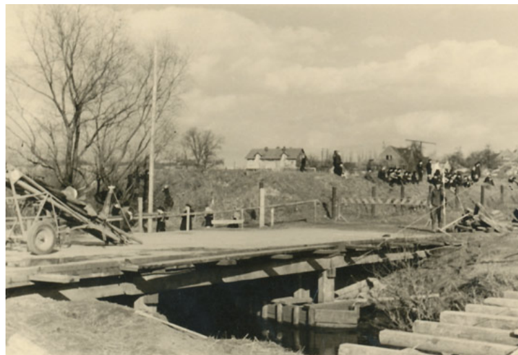
Abb. 2: Bauphase an der Wurmbrücke zwischen Palenberg und Marienberg. Sie soll das Holzprovisorium nach dem Krieg ersetzen. Foto: Stadt
