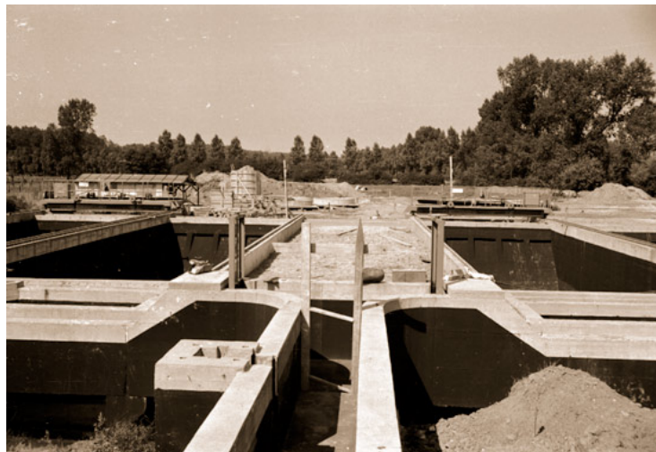
Abb. 8: Entstehungsphase der neuen Kläranlage in Frelenberg. Sie wurde notwendig, weil das Kanalnetz immer größer wurde und die Zeit der Sickergruben und Hauskläranlagen bald zu Ende gehen sollte. Foto: Stadt
