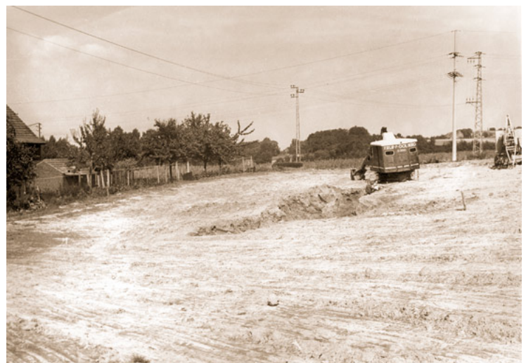
Abb. 11: Baubeginn der Schlichtwohnungen in der Nähe der Paul-Keller-Straße in Palenberg. Foto: Stadt
