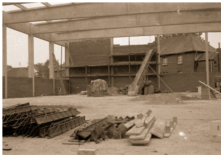
Abb. 2: Blick auf die Baustelle der Sporthalle in Palenberg, Barbarastraße. Foto: Stadt
