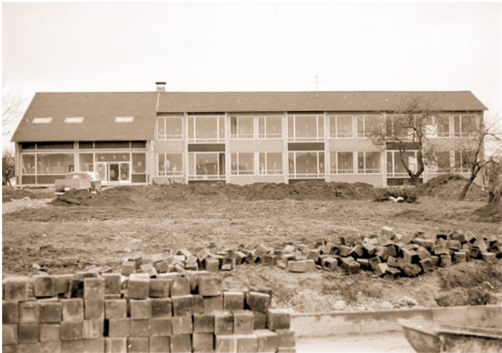
Abb. 4: Endphase des Neubaus der kath. Volksschule in Scherpenseel. Foto: Stadt
