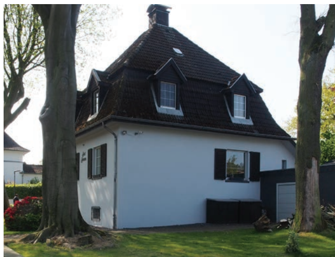
Gebäude in gutem Zustand, Carlstraße, RaumPlan
