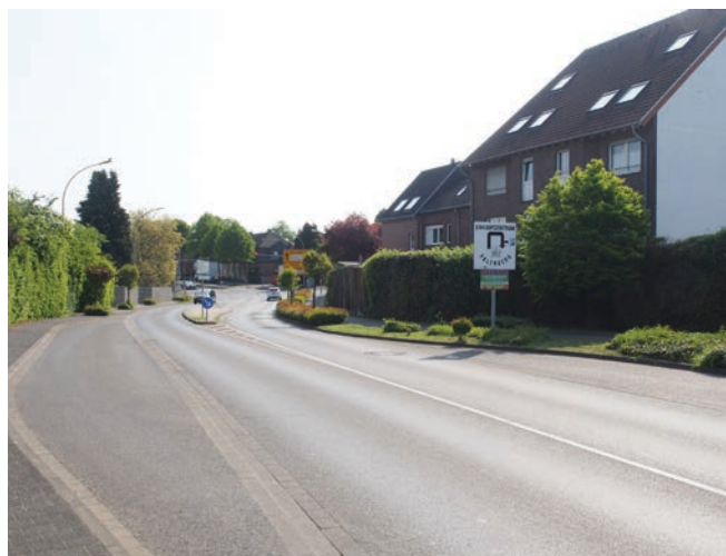
Hauptverkehrsstraße, Wurmtalbrücke, RaumPlan
