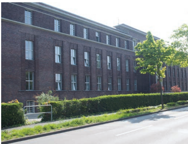
Baudenkmal ehemaliges Verwaltungsgebäude der Zeche, Carlstraße, RaumPlan
