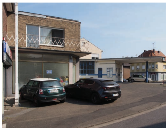
Gebäude in schlechtem Zustand, Frankenstraße, RaumPlan
