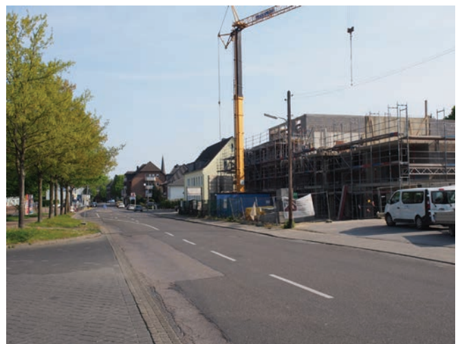
Asphalt in schlechtem Zustand, Bahnhofstraße, RaumPlan
