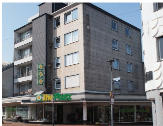
Fünfgeschossiges Gebäude, Aachener Straße, RaumPlan
