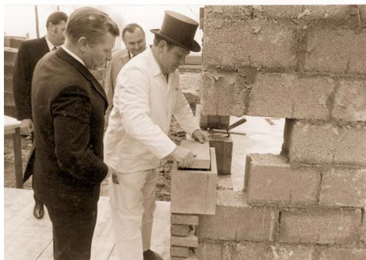
Abb. 4: Grundsteinlegung des Wohngebietes Glückaufstraße / Karolinger Straße durch Bürgermeister Max Gärtner. Foto: Stadt
