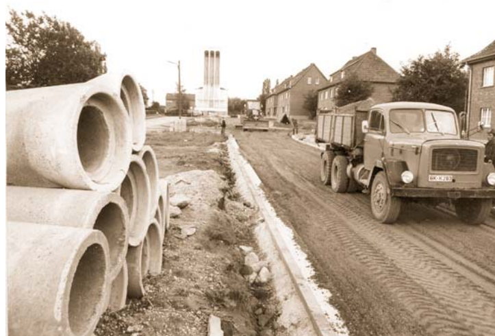
Abb. 6: Bauaktivitäten in der Carolus-Magnus-Allee in Palenberg. Die Straße sollte ein völlig neues Gesicht erhalten. Foto: Stadt
