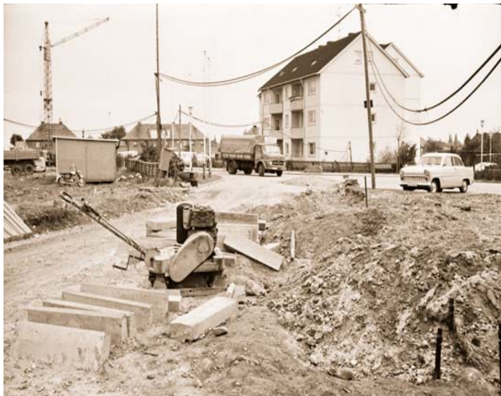
Abb. 3: Baustelle "Glückauf-Viertel" in Palenberg. Der Ausbau der Straßen schritt in diesen Monaten zügig voran. Foto: Stadt
