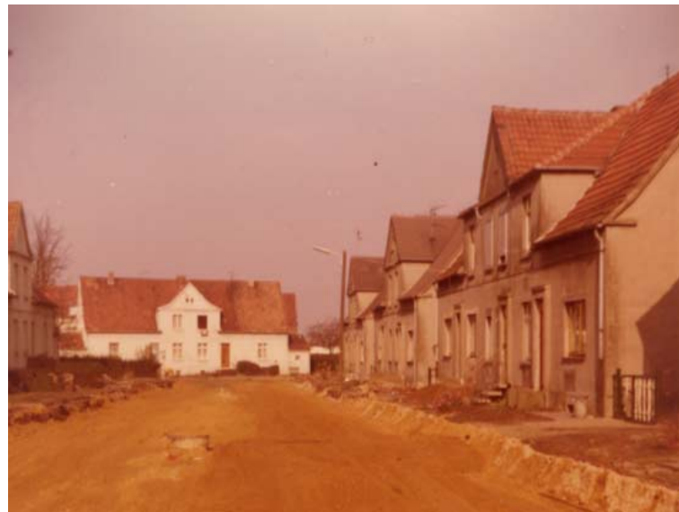
Abb. 14: Die Sanierung in Boscheln war in vollem Gang. Hier der Ausbau der Lindenstraße (späterer Nordring). Foto: Klosa
