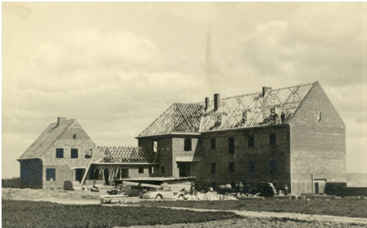
Abb. 1: Baustelle der neuen Volksschule in Marienberg, noch auf freiem Gelände, später an der nach ihr benannten Schulstraße. Foto: Stadt
