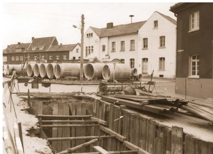
Abb. 3: Kanalisationsarbeiten vom Marktplatz bis Freiheitsstraße. Bald sollten die großen Abwasserrohre "in den Untergrund abgetaucht sein". Foto: Stadt
