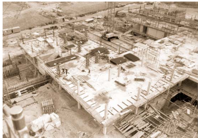
Abb. 2: Großbaustelle Schulzentrum Übach in der Anfangsphase. Foto: Stadt
