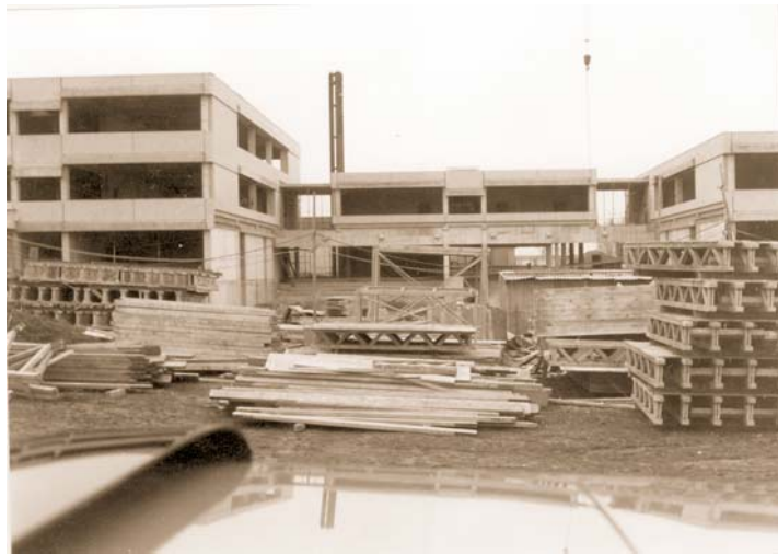
Abb. 16: Ein Blick auf die Großbaustelle des Schulzentrums Ende 1977 Foto: Stadt
