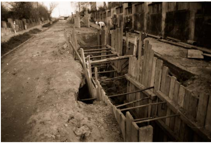
Abb. 3: Im Jahre 1978 erhielt der Heidberg in Palenberg eine neue Kanalisation. Hier waren die Arbeiten in vollem Gange. Foto: Stadt
