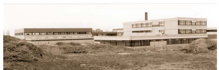
Abb. 10: Großbaustelle Schulzentrum im Jahre 1978. Die Bauarbeiten sind schon weit gekommen. Foto: Stadt
