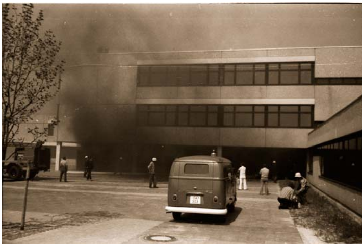
Abb. 9: Baulich fertig, noch nicht in Betrieb und schon ein Feuer. Kein guter Start des Schulzentrums in Übach-Palenberg. Foto: Stadt
