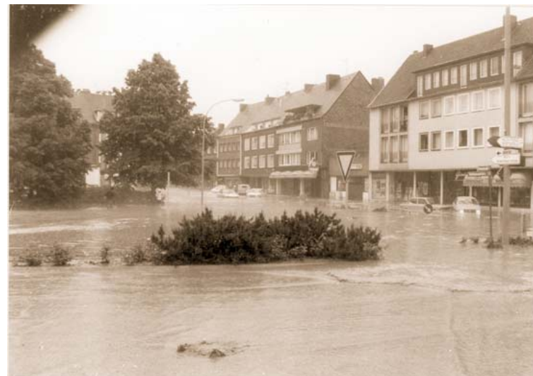
Abb. 9: Immer wieder stand der Rathausplatz bei starken Unwettern unter Wasser, wie hier im Mai 1980. Foto: Stadt
