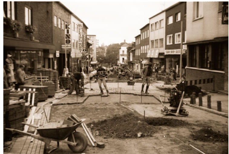
Abb.7: Im Jahre 1987 wandelte die Kirchstraße vollkommen ihr Gesicht. Hier wird gerade der Belag der künftigen Straße aufgetragen. Foto: Stadt
