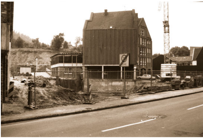
Abb.10: Hier entsteht die spätere Bebauung des „Koddes“ mit kombinierten Wohn- und Geschäftshäusern im Weichbild der Talstraße. Foto: Stadt
