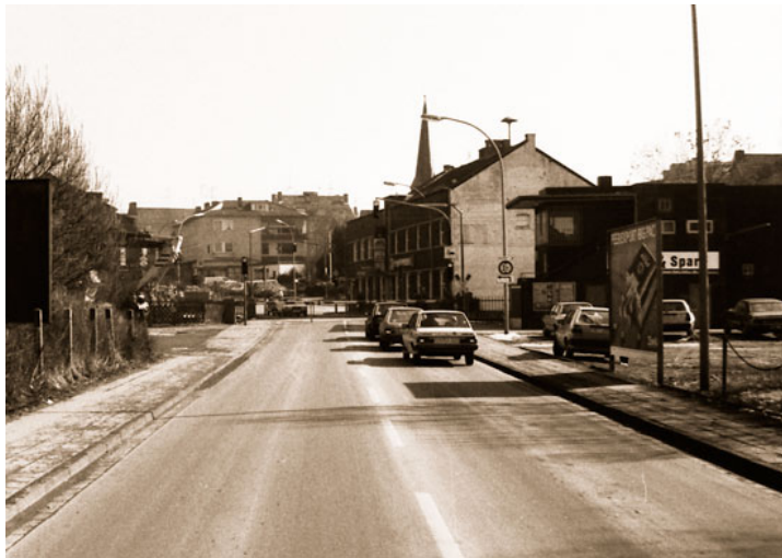
Abb.2: Ein alltägliches Bild. Mehr oder weniger lange Autoschlangen warten vor dem Bahnübergang Frankenstraße / Hotel Ernst. Ein Brückenbauwerk über Bahnlinie und Wurm wurde auf Grund der stets größer werdenden Verkehrsentwicklung immer notwendiger. Foto: Stadt
