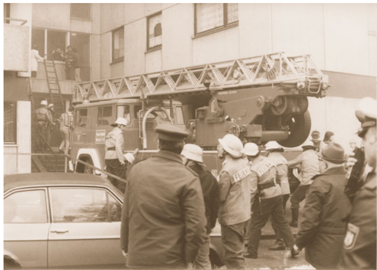
Abb.4: Großer Feuerwehreinsatz in der Werkstraße. Mit der Drehleiter wurden zahlreiche Bewohner aus dem rauchenden Gebäude evakuiert. Foto: Stadt
