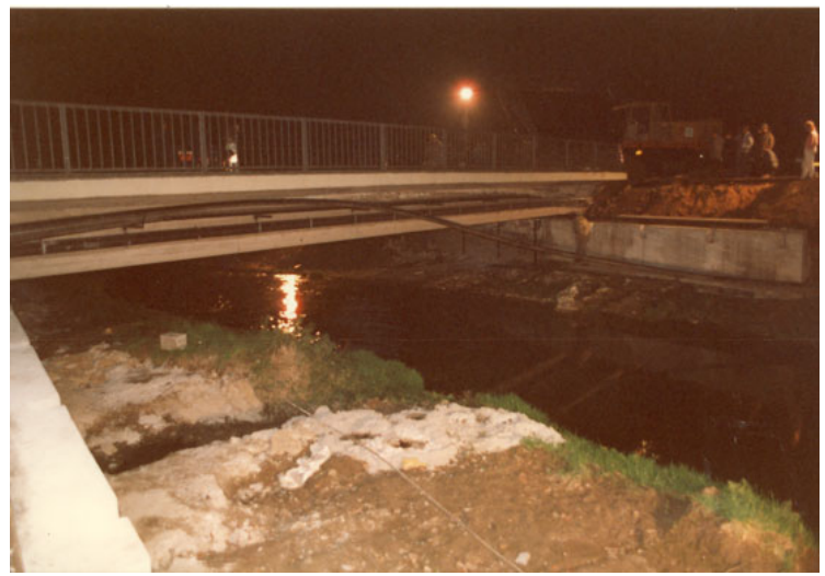
Abb. 17: Bevor die große Brücke über Bahn und Wurm gebaut werden konnte, musste die kleine Brücke bei Marienberg versetzt werden. In einem Präzisionsarbeitsgang "wanderte" sie einige Meter weiter. Foto: Stadt
