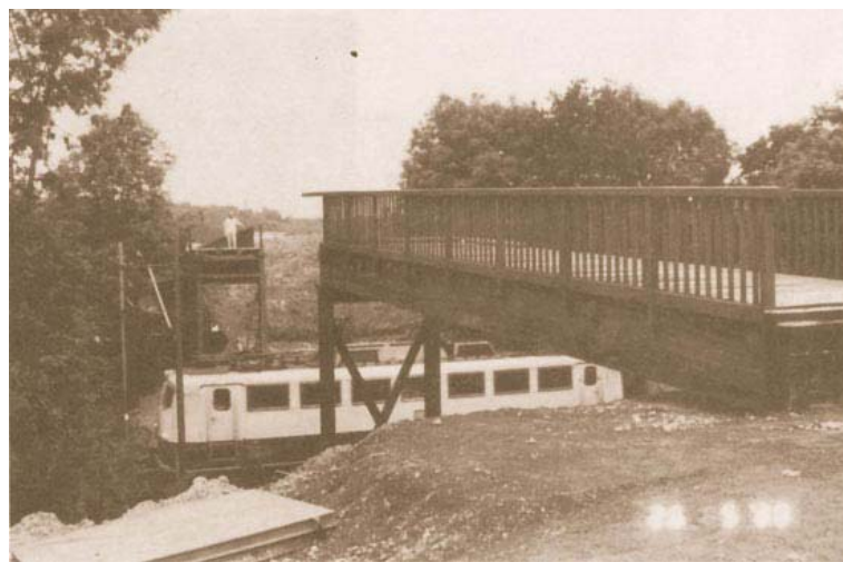
Abb. 9: Eine kleine Brücke entstand im Jahre 1988 als fußmäßige Zuwegung zum noch im Bau befindlichen Naherholungsgebiet Wurmatal und zwar von der Aachener Straße aus über die Bahnlinie. Foto: Stadt
