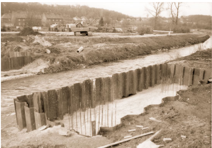
Abb. 12: Direkt neben der Wurm wurden gewaltige Fundamente in den Boden eingelassen. Hier wurden zahlreiche Kubikmeter Beton verbaut. Foto: Stadt
