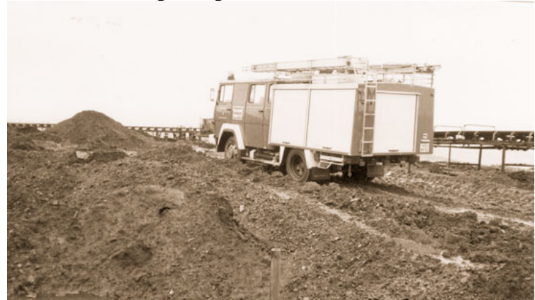
Abb. 20: Eine Feuerwehrrüstung im Dezember 1988 auf der Bergehalde Carolus-Magnus. Noch sind die Spuren der Kohlenrückgewinnung in diesem Bereich sichtbar.
